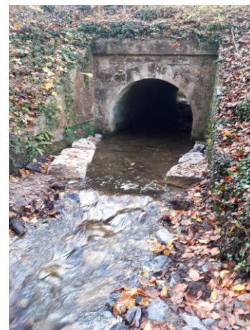
PRE BARRAGE EN ENROCHEMENT POUR RETABLIR LA FRANCHISSABILITE
