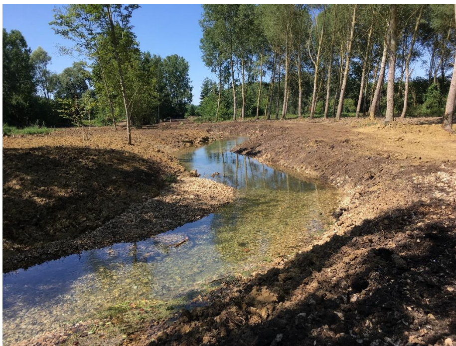
RECHARGE GRANULOMETRIQUE D'UN TRONÇON REMEANDRE SUR LA VERSE A NOYON (60)
