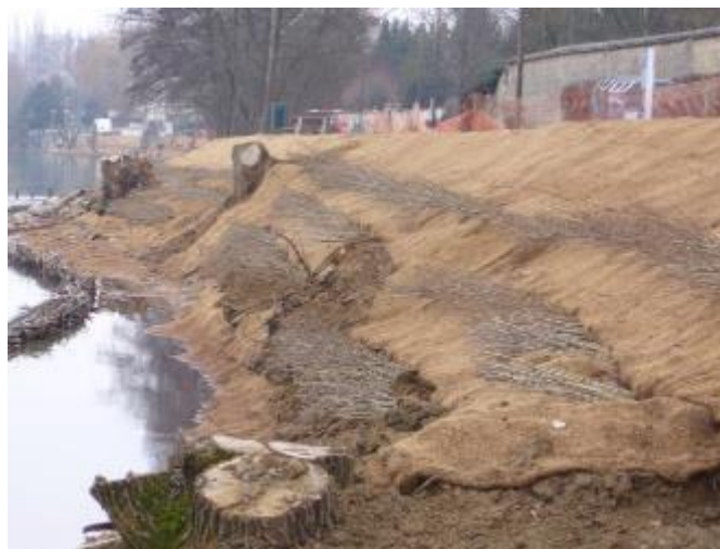
EXEMPLE D'UN CHANTIER (INGETEC 2010, L'OISE A ERAGNY)
