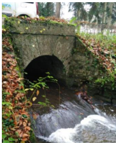
OUVRAGE INFRANCHISSABLE SUR LE RU DE BERNE (FORET DE COMPIEGNE 60)
